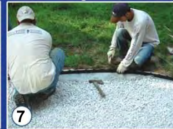
Install Edge Restraint
